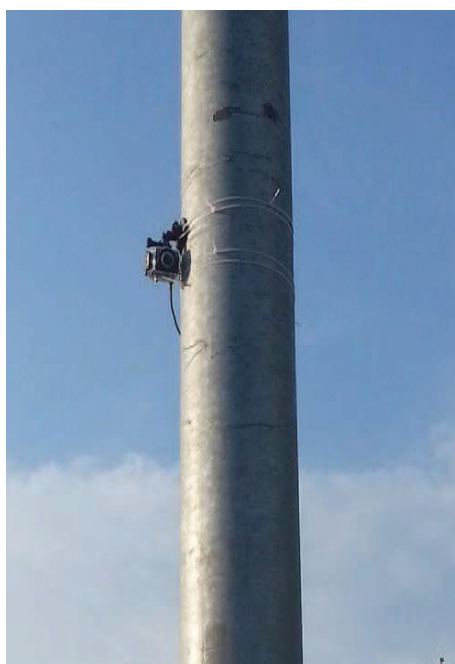
Рисунок 5 – Монтаж видеокамеры на столб линии электроосвещения
